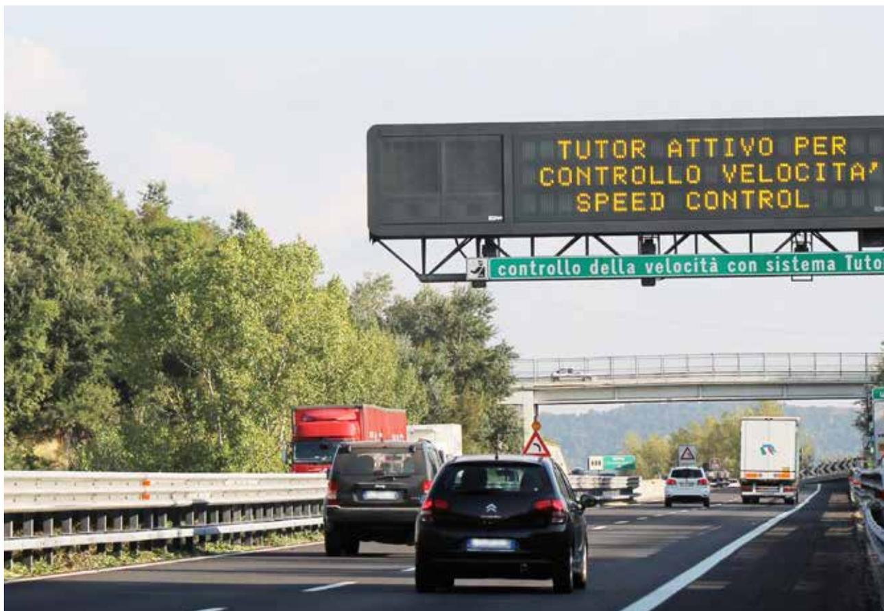
I principali sistemi tecnologici della piattaforma sono costituiti da radar, telecamere, server periferici e un sistema centrale: una combinazione di tecnologie in grado di rilevare la velocità media del veicolo, segnalandolo, per opportune verifiche, in caso di superamento dei limiti, in caso di circolazione su corsie non consentite e in caso di verifica del rispetto dell'obbligo di destra rigorosa da parte dei veicoli pesanti.
